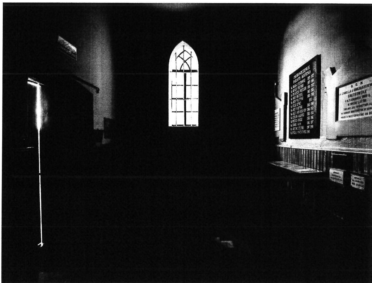
Kruchta południowa kościoła pw. Świętej Trójcy w Kłótnie, obecny stan zachowania.
