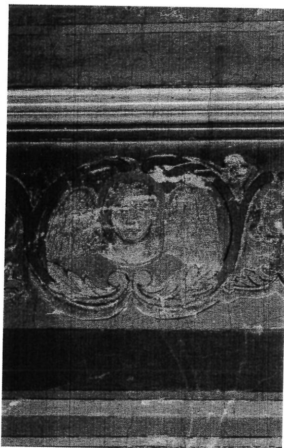
Polichromie ściennie w kościele pw. Świętej Trójcy w Kłótnie, widoczne spudrowane przedstawienie aniołka.
