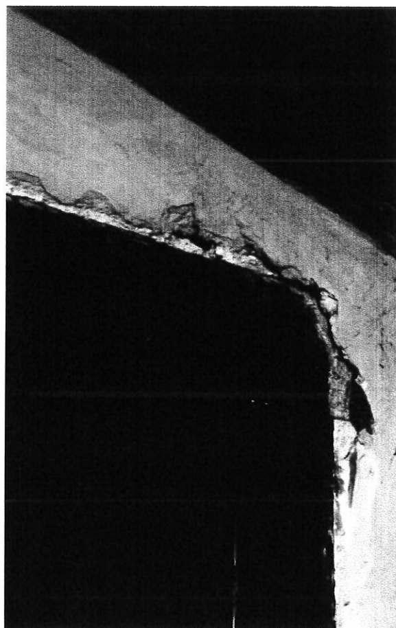
Zakrystia południowa w kościele pw. Świętej Trójcy w Kłótnie, obecny stan zachowania, ubytki tynku przy drzwiach.
