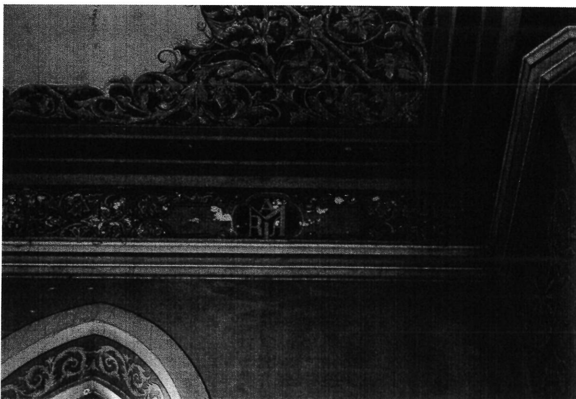
Polichromie ścienne w kościele pw. Świętej Trójcy w Kłótnie, nawa, widoczne ubytki warstwy malarskiej na sklepieniu.
