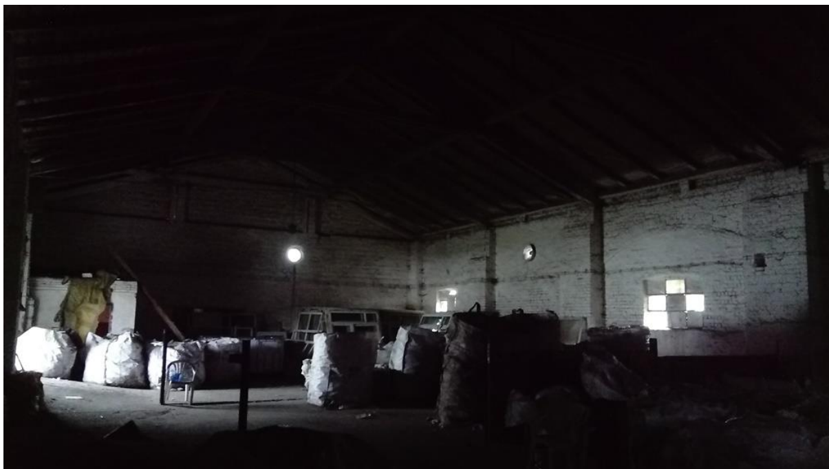
Foto 2. Widok wewnętrzny budynku b. magazynu zbożowego w Baruchowie
